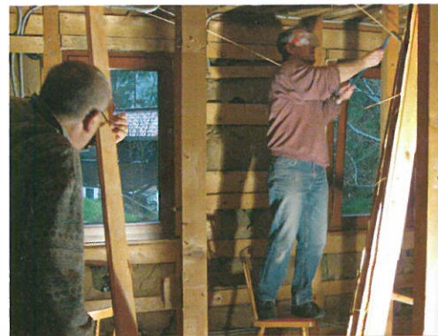
Vorher – nachher: Zahlreiche Helfer haben die Schlafräume im Haus 34 im Kolping-Feriendorf Ebnit modernisiert.
